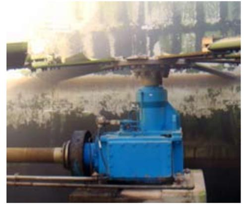
Ventilatore industriale n° 7 - è evidente la rottura di una delle pale
